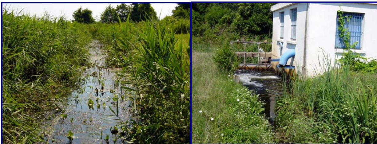
Figure 5 : Vues de la station de prélèvement P3 à gauche et de la station de pompage, à droite
