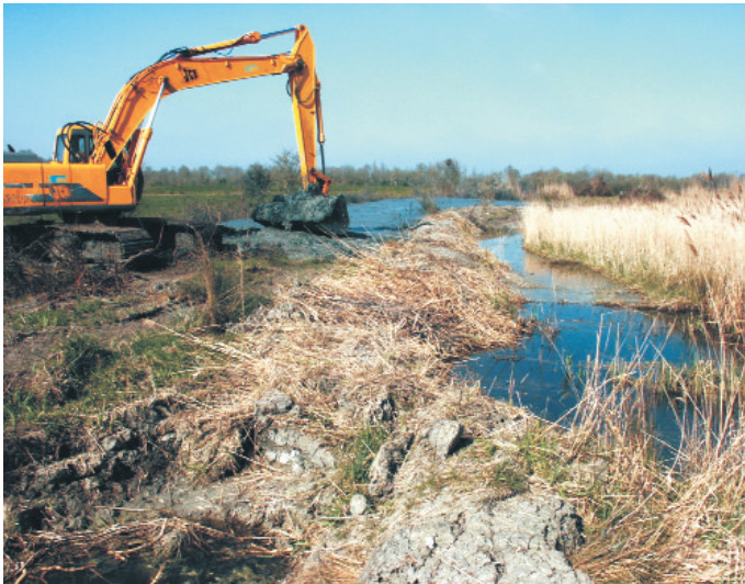
Fig.27 - Dépôt de la vase avec confection d'un bourrelet pour éviter son intrusion sur une roselière.
