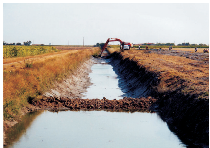
Fig.16 - Curage à sec avec mise en place de diguettes (batardeaux).
