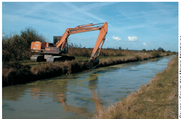
Fig.17 - Curage en eau.
