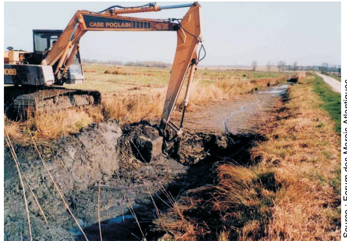
Fig.7 - Re-creusement d'un fossé atterri afin de restaurer sa fonction hydraulique.
