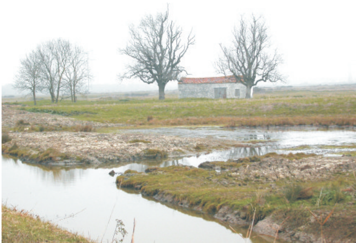
Fig.24 - Fossé en relation avec une prairie humide inondable (marais de Brouage). Le bourrelet de curage est interrompu pour permettre la libre circulation de l'eau. Dans certains cas, si l'on veut conserver plus longtemps de l'eau sur les parcelles, il est au contraire intéressant de demander le dépôt sur la jonction.
