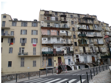
Photo 3 Edicules et fentes sous balcons dans le bâtiment de droite qui n'a pas encore fait l'objet d'une rénovation
