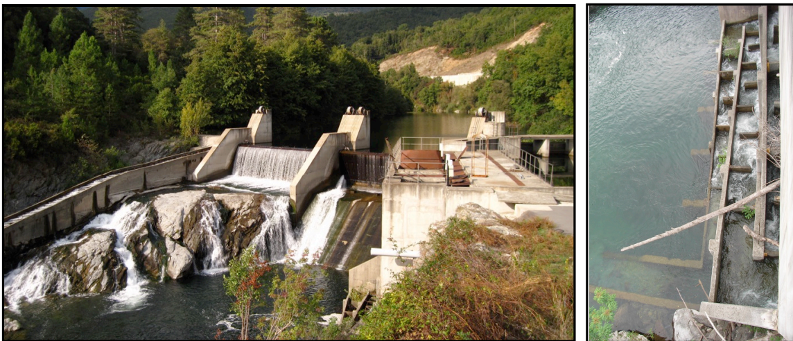
Figure 14 : Le barrage hydroélectrique de Cardiccia et sa passe à poissons. MRM
