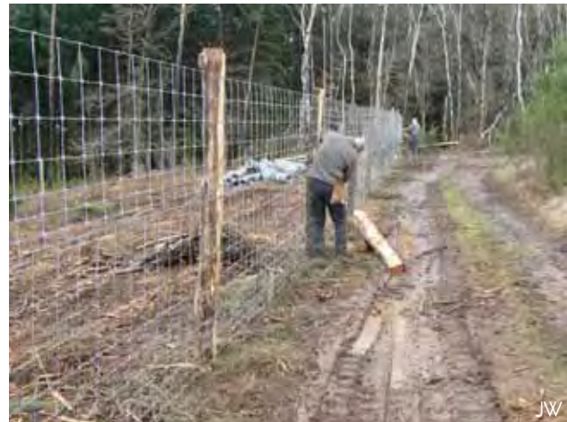
Les clôtures contre le cerf doivent atteindre au minimum 2 m de hauteur
