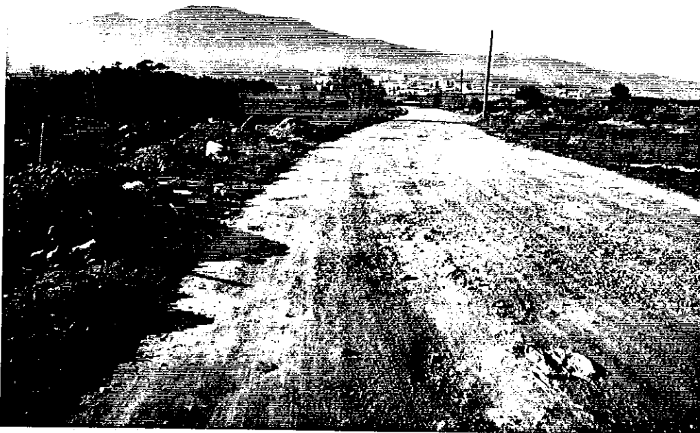
Le chemin trop large et dégradé qui mène au grau devrait retrouver l'aspect d'un sentier accueillant
