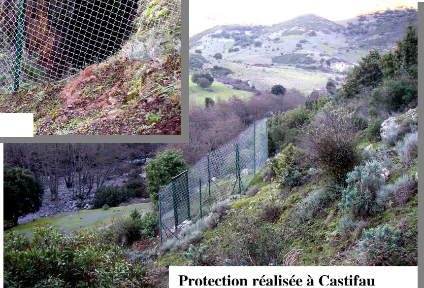
Protection réalisée à Castifau
