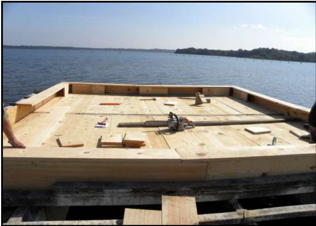
Figure 5 : Mise en place du plancher et des chicanes (Photo Lepori L.)
