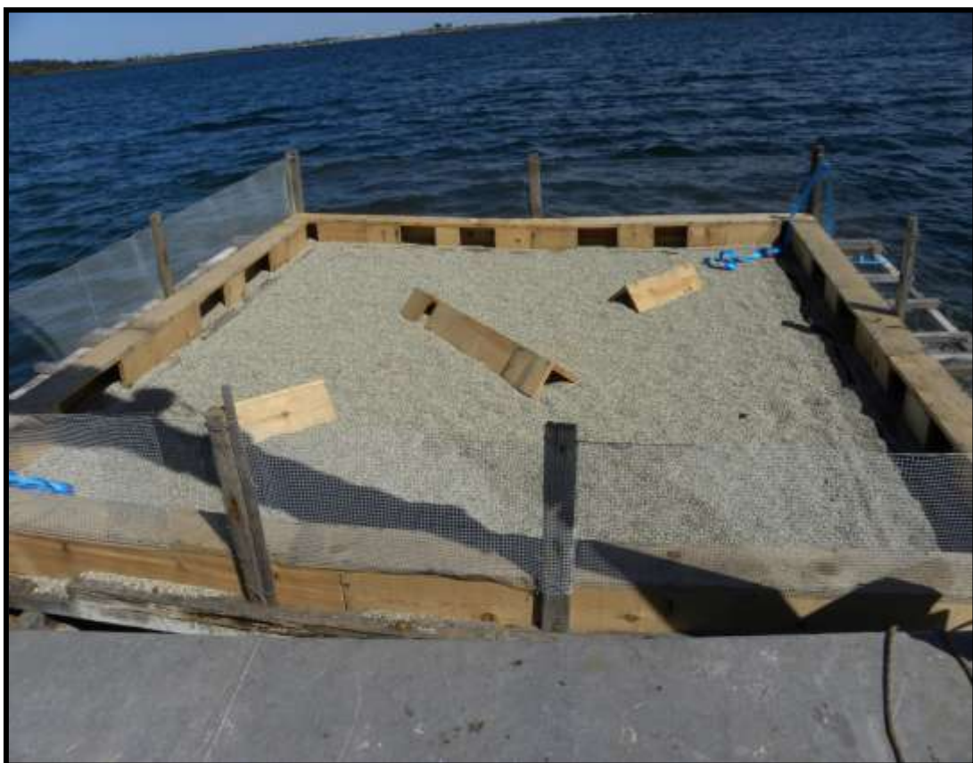
Figure 6 : Radeau fini, avec le gravier, le grillage et les abris (Photo Lepori L.)
