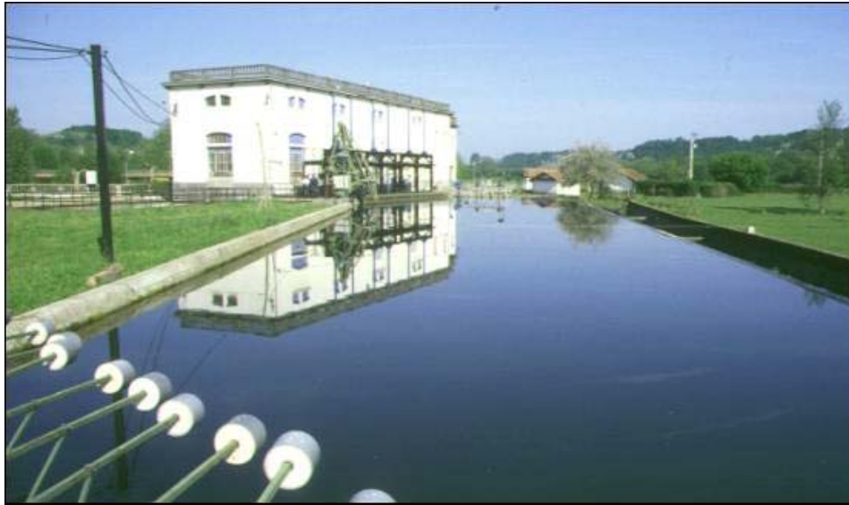
Photo 12 : Vue amont de la microcentrale hydroélectrique d'Halsou et du canal d'amenée. La partie visible de l'usine correspond à la prise d'eau (photo C. Gosset).
