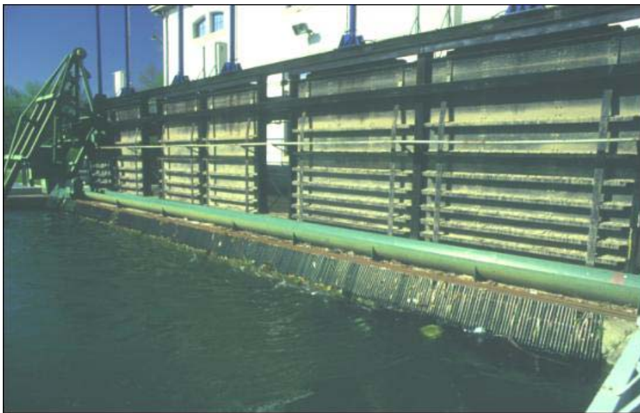
Photo 13 : Prise d'eau de l'usine et grilles de protection des turbines. Le dégrilleur automatique est visible sur la gauche (photo C. Gosset).
