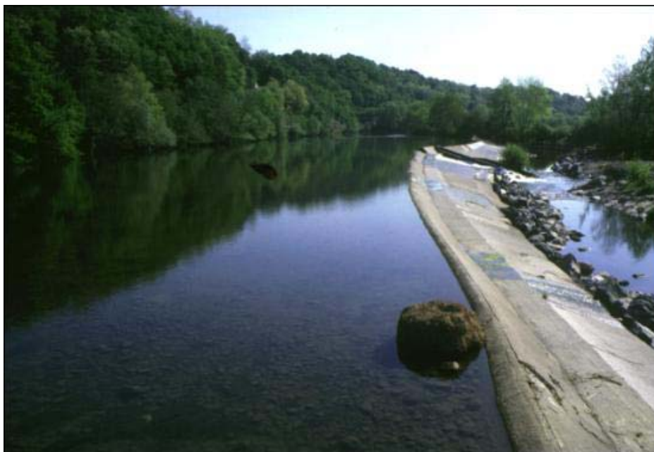
Photo 11 : Barrage d'Halsou situé en amont de l'usine hydroélectrique. Ce barrage est équipé d'une passe à ralentisseurs, (photo C. Gosset).
