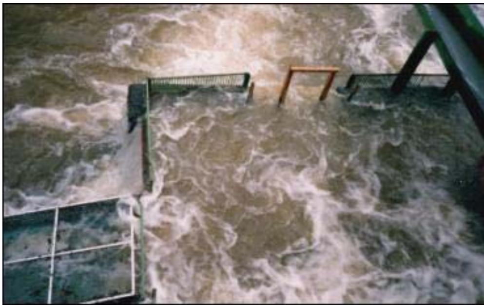
Photo 16 : Vue du dessus du bassin de réception sur lequel une ouverture munie d'un écran électrique permet l'évacuation des débris tout en empêchant la fuite des poissons (photo F. Travade).
