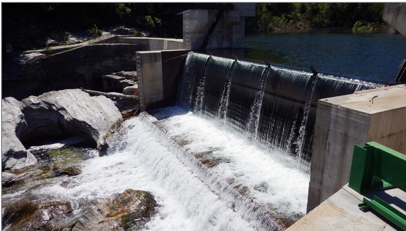
Figure 3: Centrale de Lucciana-Olmo sur le Golo (ROE40775)
