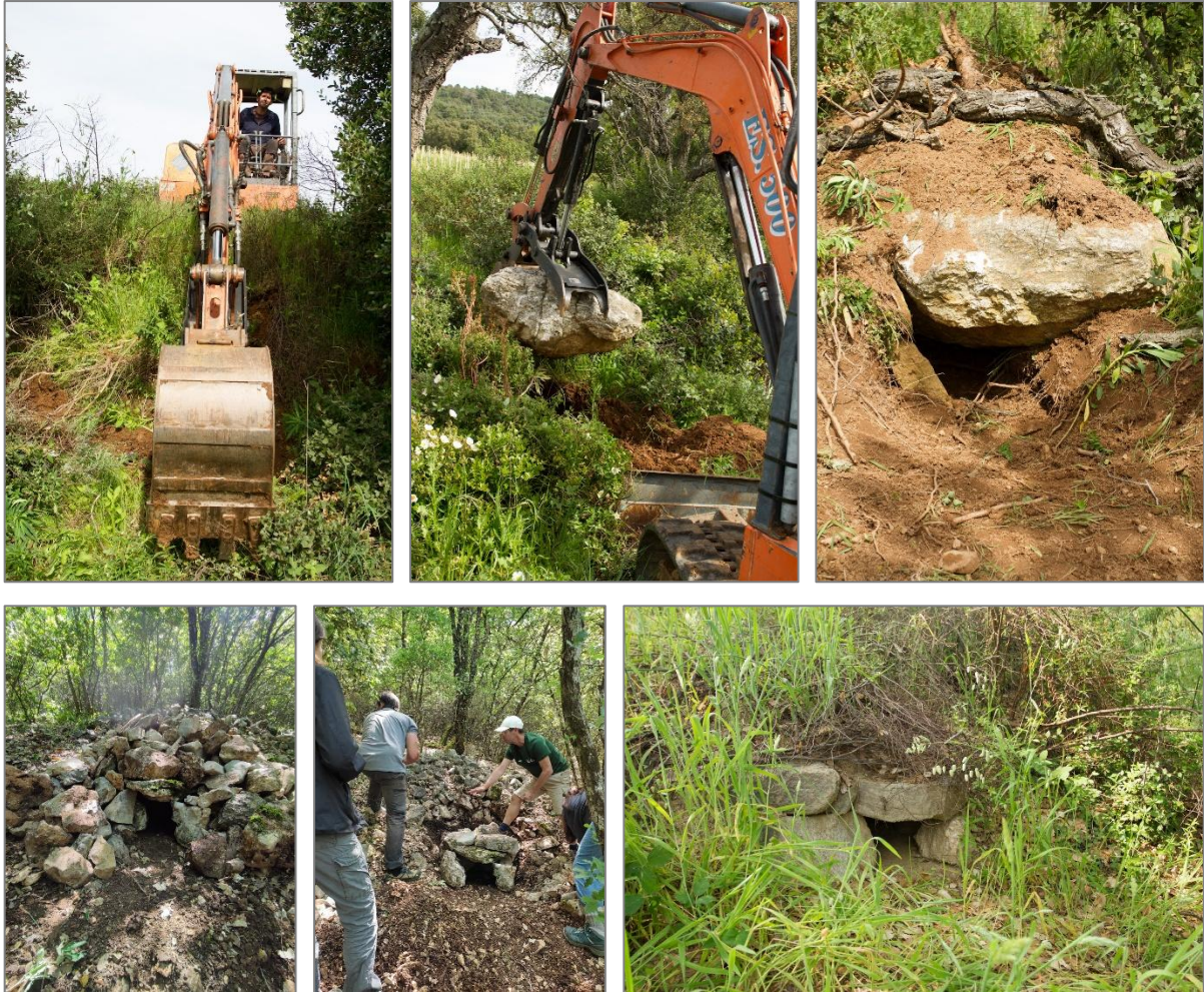
Abris anti-feu réalisés en 2025 sur Capelude, Redon et en 2024 au Château de la Môle © J. CELSE et J. VIDAL
