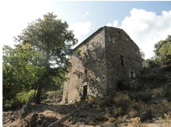
Il y a des problèmes d'infiltration d'eau via la toiture dans la maison, qui à plus ou moins long terme risque de la mettre à mal (effondrement de la toiture). Des tuiles se sont déplacées. Elles ont été tant bien que mal remises en place ce jour là.
